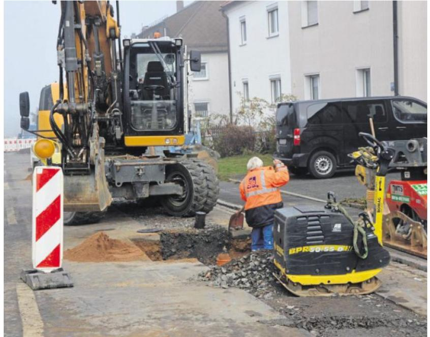
Bei der Auswechslung der Wasserleitung und der Erstellung der Hausanschlüsse in der Pfaffenreuther Straße dauern die Arbeiten an.
